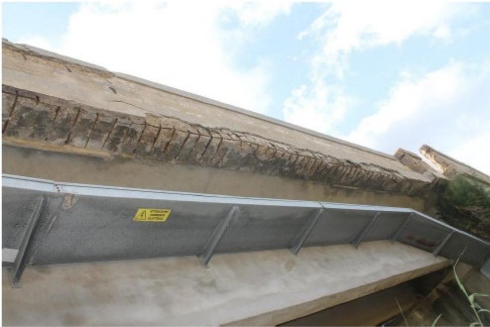
Foto 36 - Particolare sbalzo soletta lato sx , Campata I - Macchie umidità attiva, cls dilavato, distacco copriferro, staffe scoperte e ossidate, armatura ossidata
