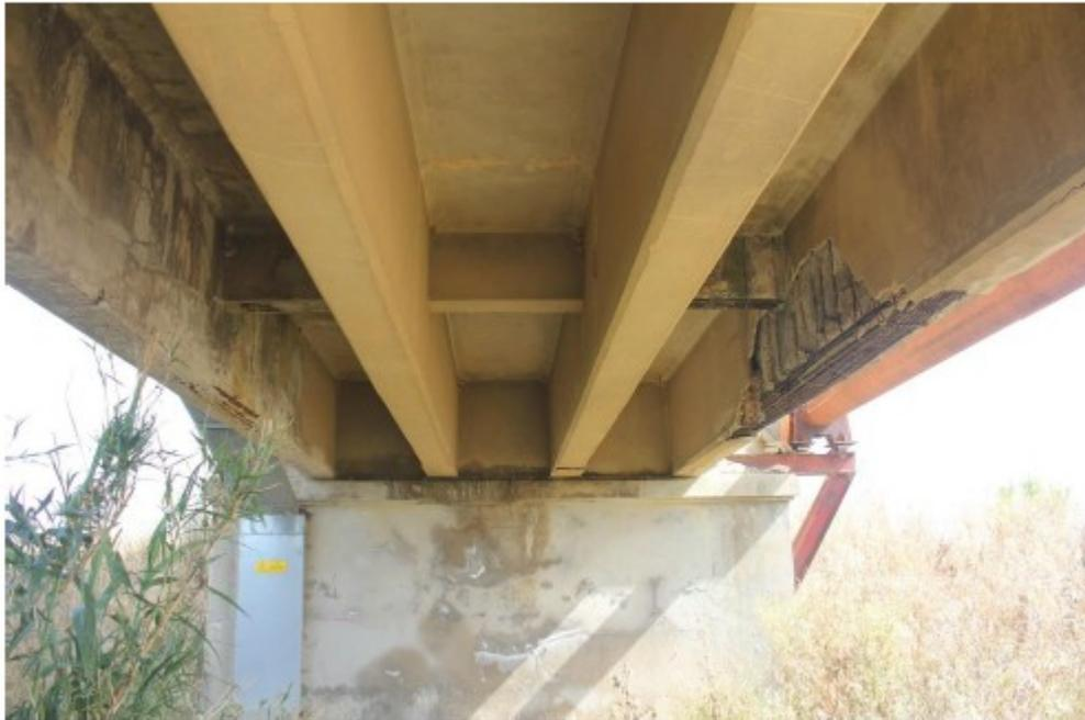
Foto 27- Travata Campata III / spalla lato monte -Distacco Copriferro, armatura ossidata, staffe scoperte, ossidate e rotte, umidità attiva soletta, travi e traversi
