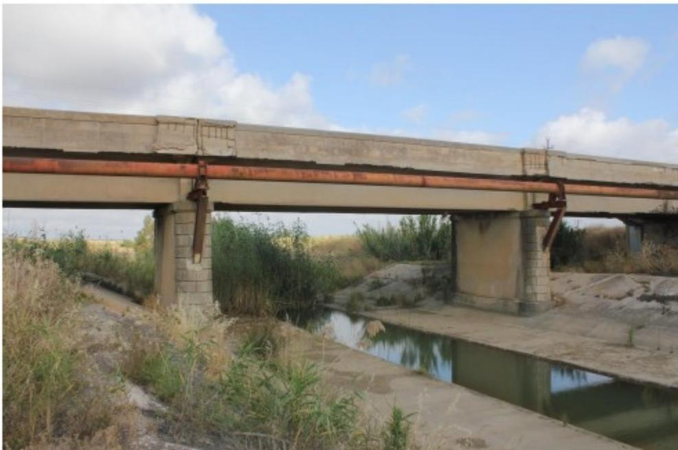
Foto 9 - Prospetto ponte lato dx - Macchie di umidità e dilavamento pile, presenza di sottoservizi
