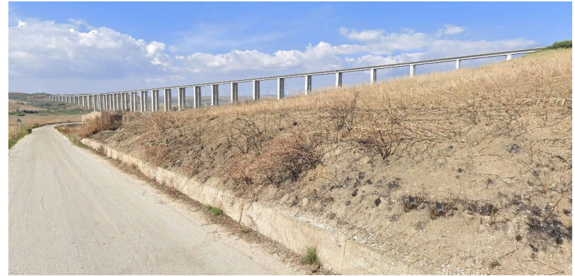
Figura 3 12 - Alternativa 2A raddoppio in quota Viadotto Carboj
