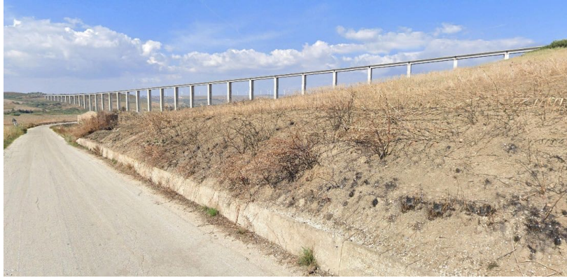
Figura 3 11 - Stato attuale Viadotto Carboj
