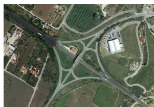
Figura 3-6- Svincolo di Menfi
