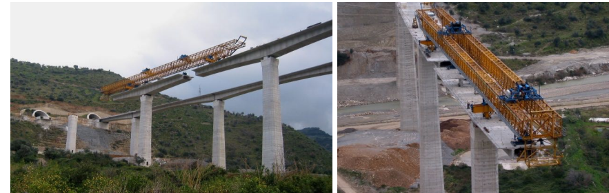
Figura 3-13 – Alternativa 2A e 2B – Esempio di carro varo sull'autostrada Messina – Palermo
